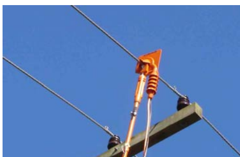
Figura 3 – Fixação da garra (sensor) no cabo.
