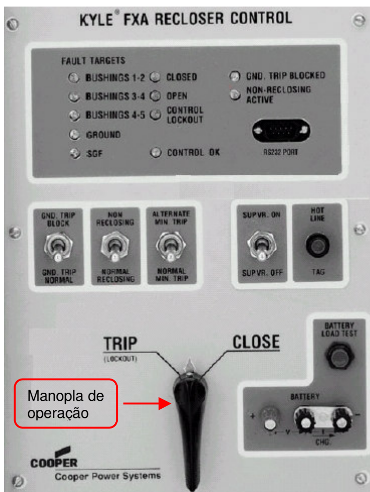
Figura 4 – Religador com controle FXA.
