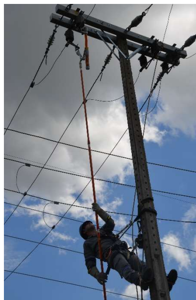
Figura 8 – Posição recomendada para operação de Load Buster em poste.
