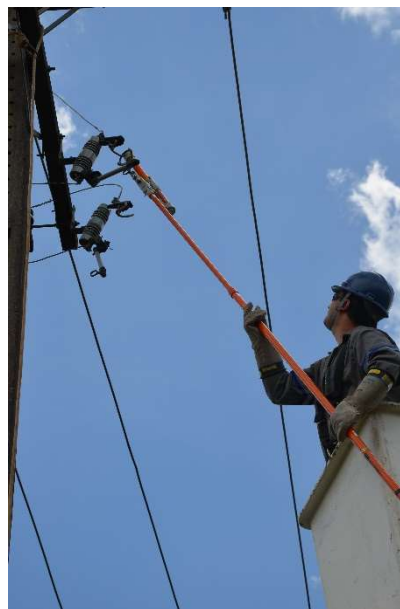
Figura 7 – Posição recomendada para operação de Load Buster em cesta aérea.
