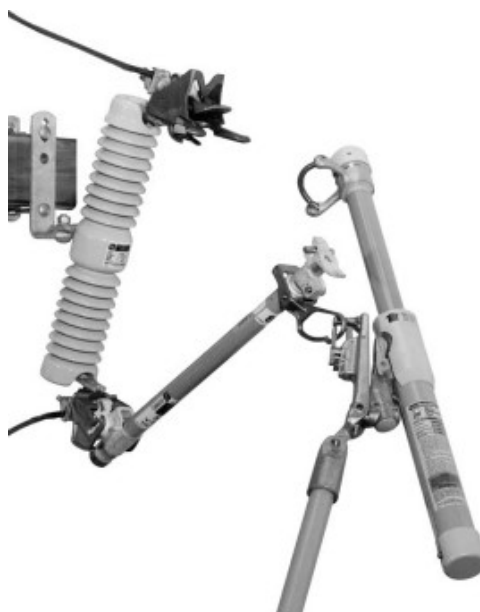
Figura 5 – Retirando a Loadbuster da chave fusível.
