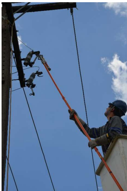
Figura 7 – Posição recomendada para operação de Load Buster em cesta aérea.
