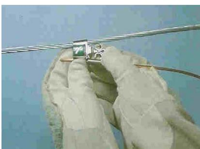
4º Passo: Complete a conexão usando o alicate tipo bomba d'água para todos os tipos de conectores.
