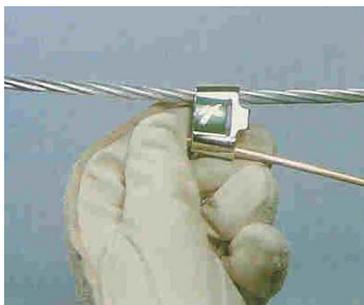
3º Passo: Ajuste a cunha entre os condutores usando apenas a pressão dos dedos, verificando a posição correta da trava.
