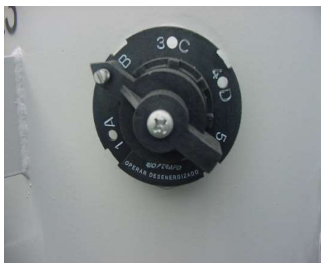
Figura 3 - Parafuso de fixação do comutador.
