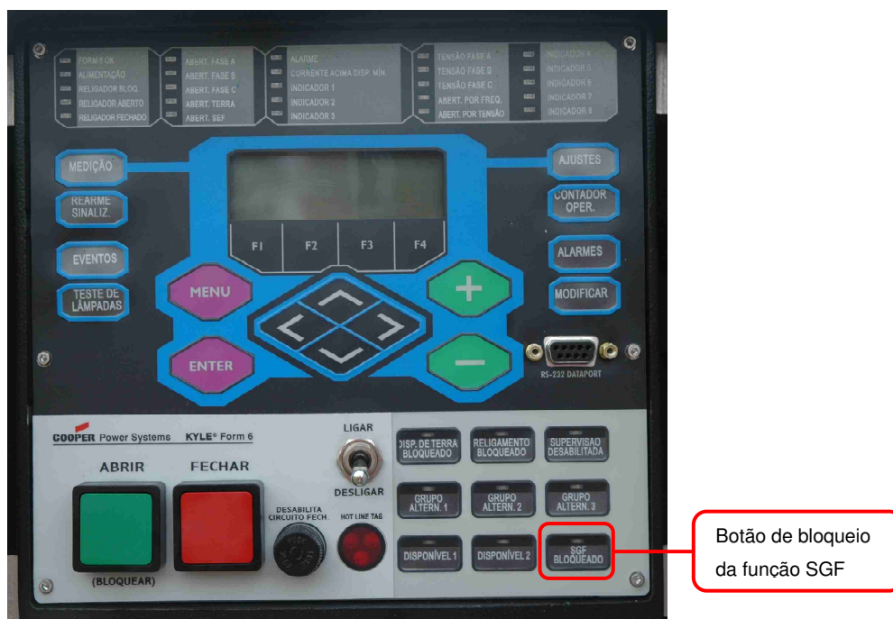
Figura 3 – Religador com controle F6.
