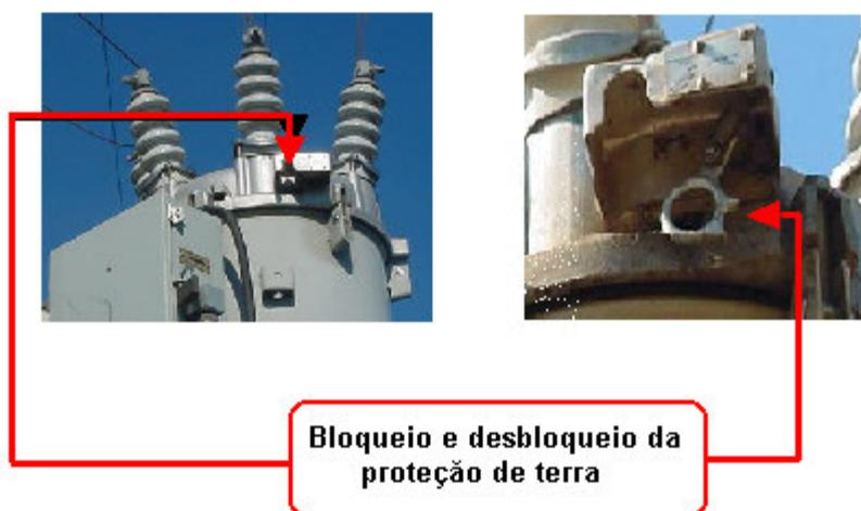
Figura 2 – Religador KFE e detalhe da alavanca de bloqueio da proteção de terra.
