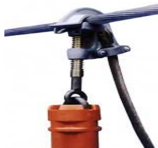
Figura 6 – Colocação de aterramento temporário
