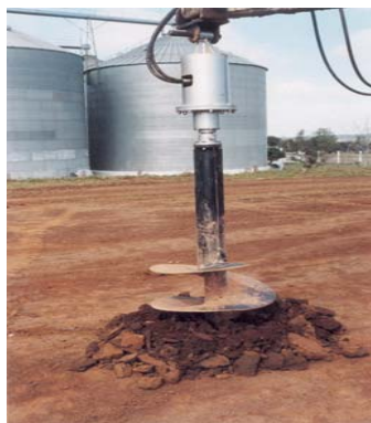
Figura 14 – Perfuratriz acoplada ao guindauto
